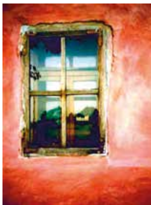
Слика 1: Детаљ фасаде, Надаљ
